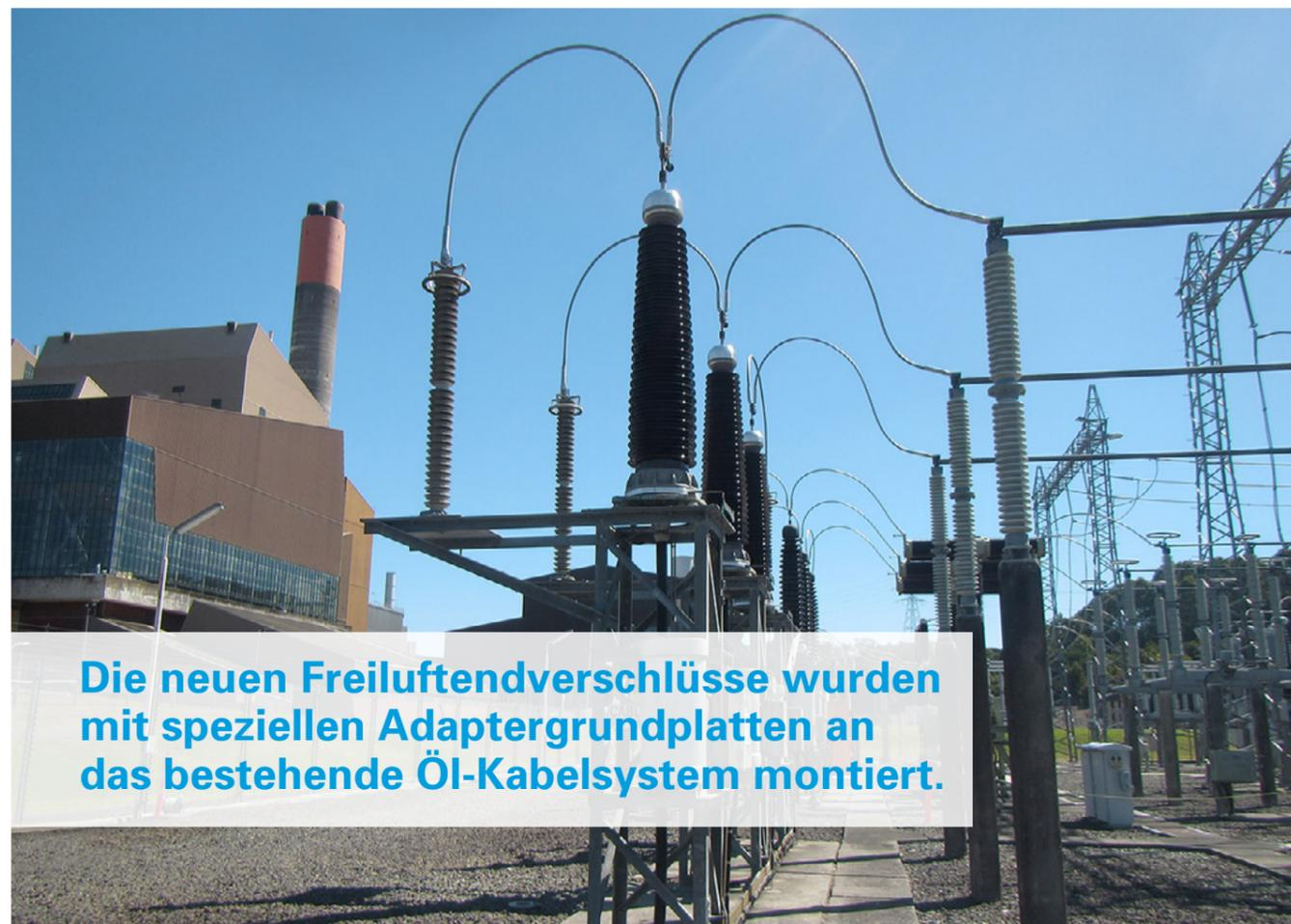
**Die neuen Freiluftendverschlüsse wurden mit speziellen Adaptergrundplatten an das bestehende Öl-Kabelsystem montiert.**
