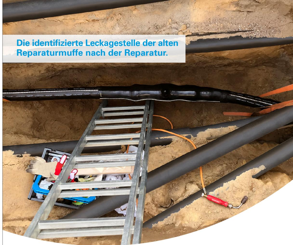
Die identifizierte Leckagestelle der alten Reparaturmuffe nach der Reparatur.
