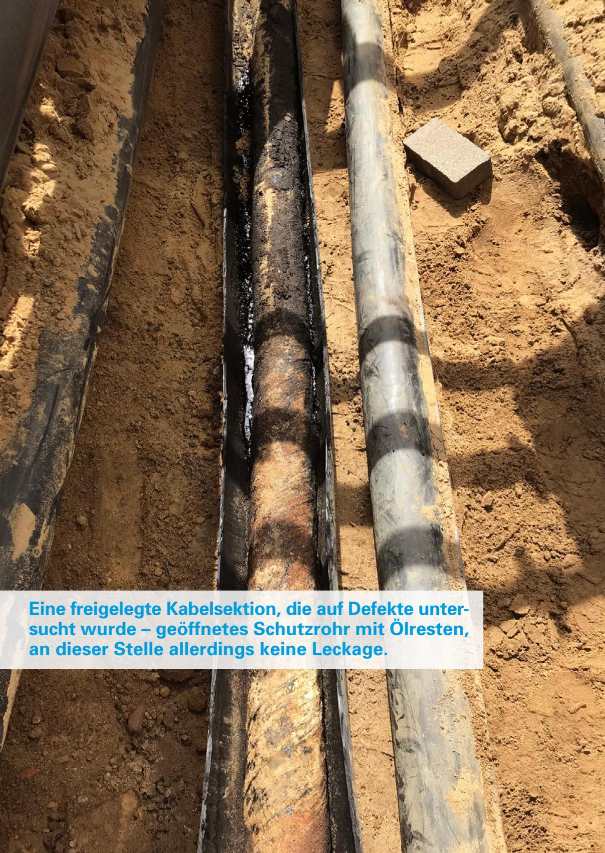
Eine freigelegte Kabelsektion, die auf Defekte untersucht wurde – geöffnetes Schutzrohr mit Ölresten, an dieser Stelle allerdings keine Leckage.
